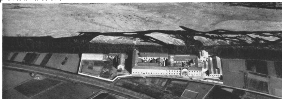
Pl. XXIX, A — Papeterie à Capellades, sur le Rio Noya
